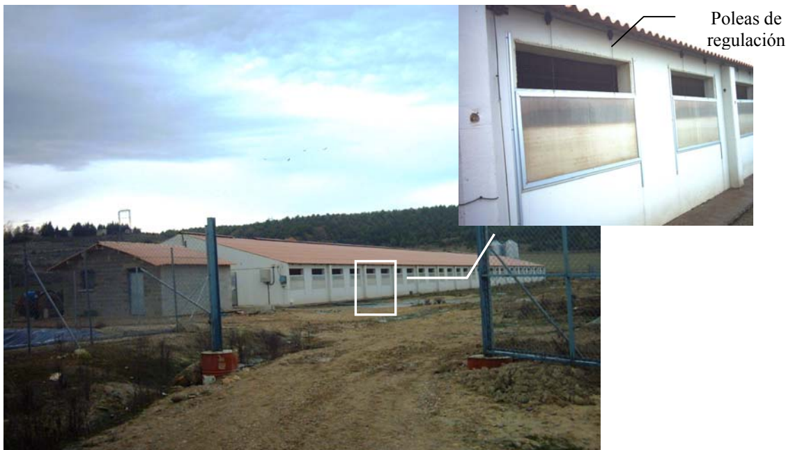
Figura 21: Cebadero con ventilación natural y ventanas de guillotina
